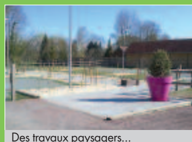
Des travaux paysagers...
