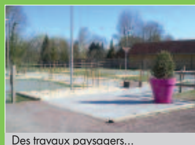
Des travaux paysagers...
