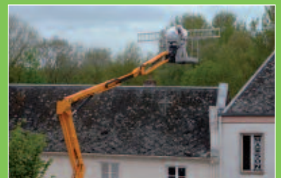
La démolition au 52 rue Victor Hugo
