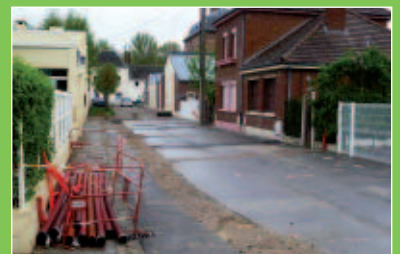
Les branchements gaz électricité rue Eugène Desprès
