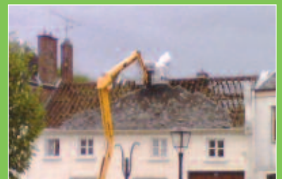
Les travaux avancent...
